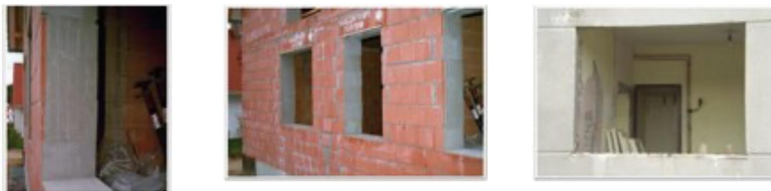
Slika 7.2 - 1 Priprema građevinskog otvora za RAL montažu
