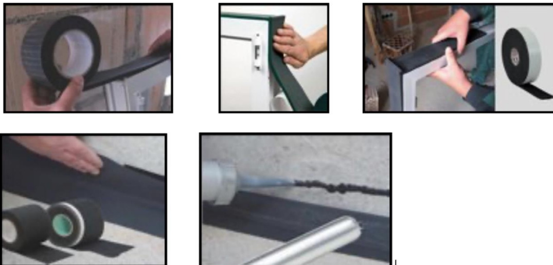
Slika 7.3 - 1 Ilustracija ugradnje pomoću traka
